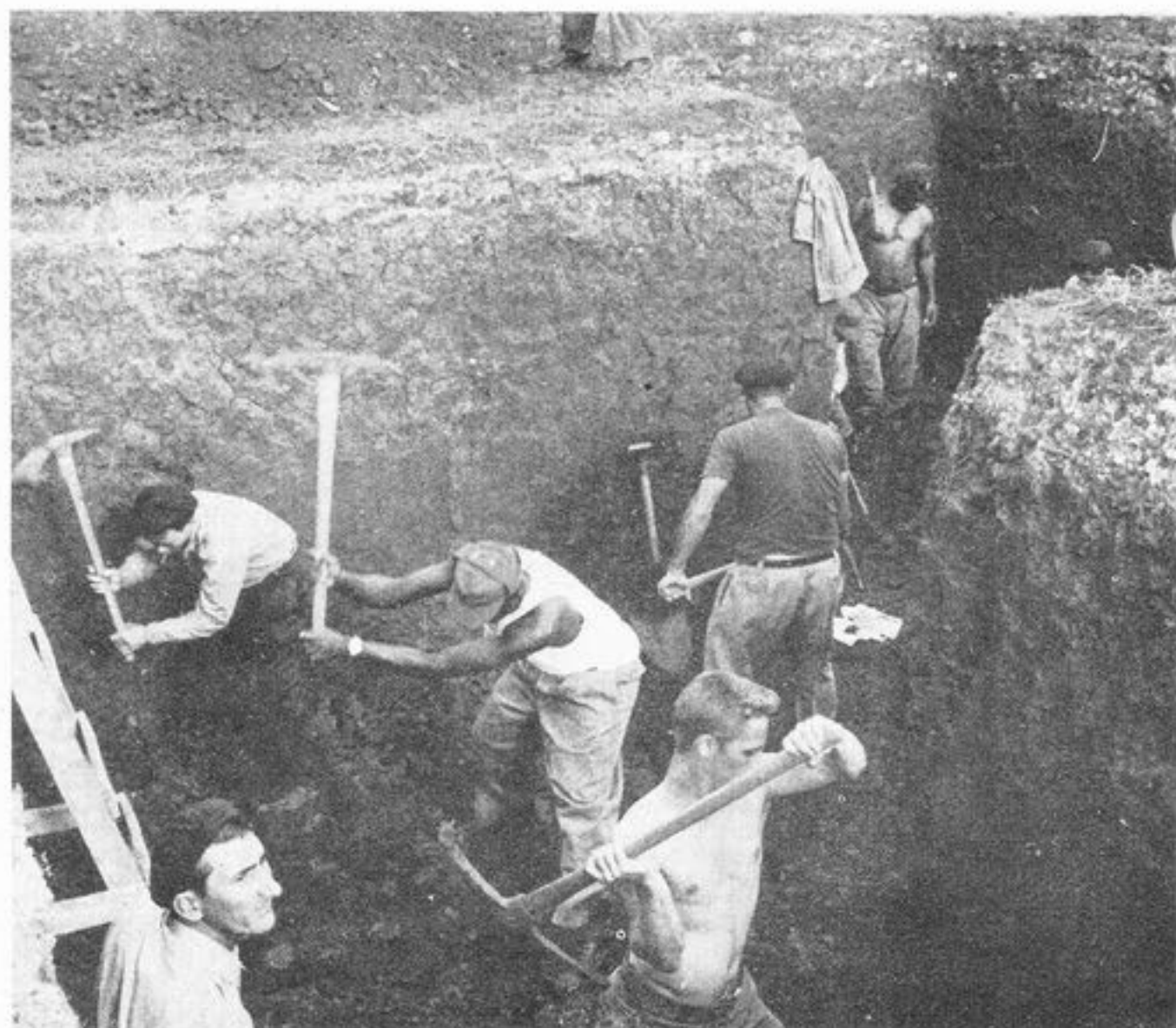
Los milicianos cavan una trinchera, que será un baluarte de la defensa.
